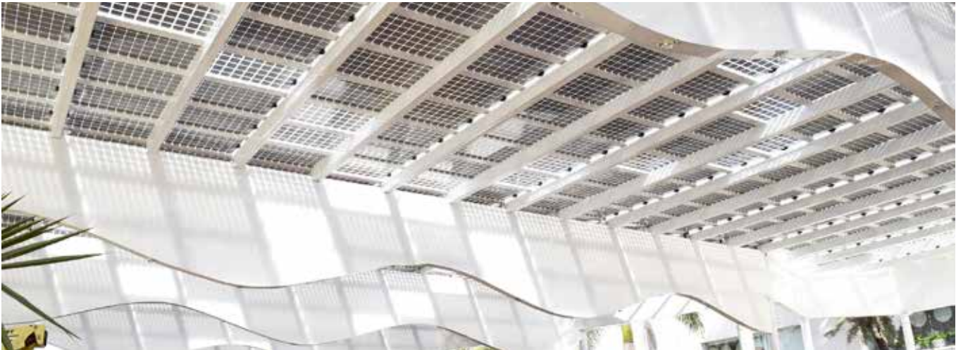
Paneles Semitransparentes Hotel HOTSSON, León, Gto. | Potencia de 245.5 kWp
